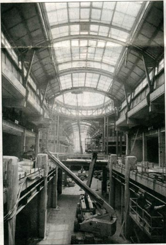
Zwei Jahre von der Grundsteinlegung bis zur Einweihung, das ist der Zeitplan für das zwei Milliarden Mark teure Bauprojekt.
