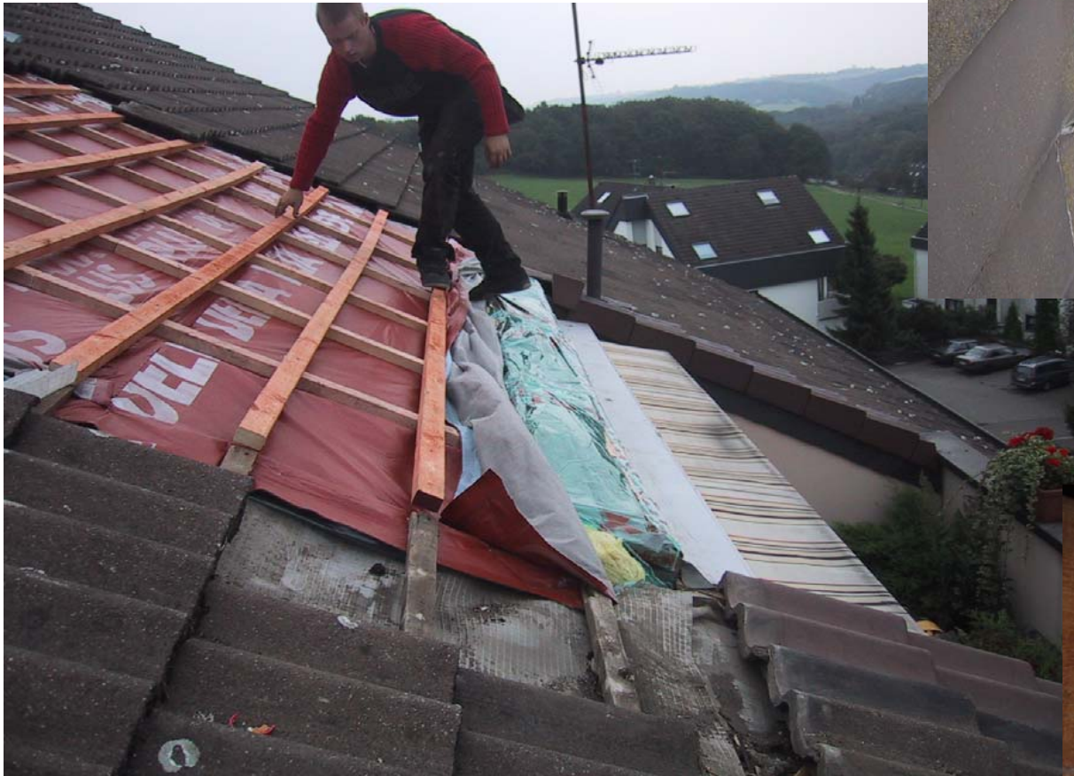
vorhandene lückenhafte Wärmedämmung
