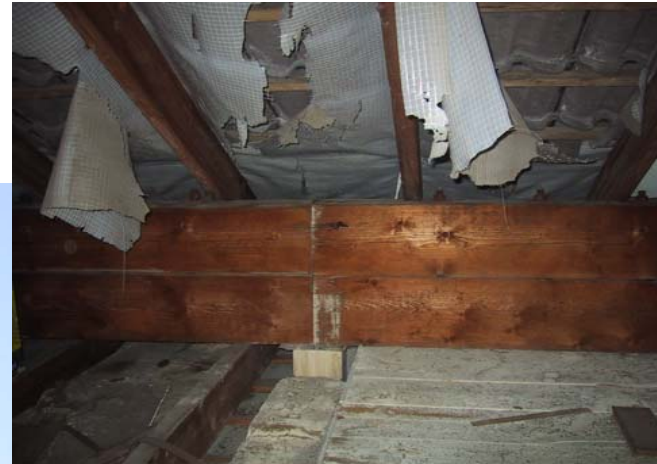
defekte Dachbahnen
