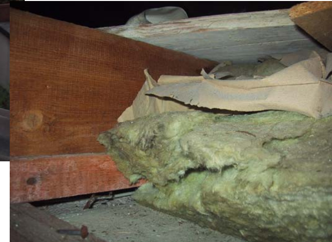
vorhandene lückenhafte Wärmedämmung
