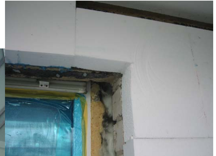
Fenstereckausbildung der Fassadendämmung
