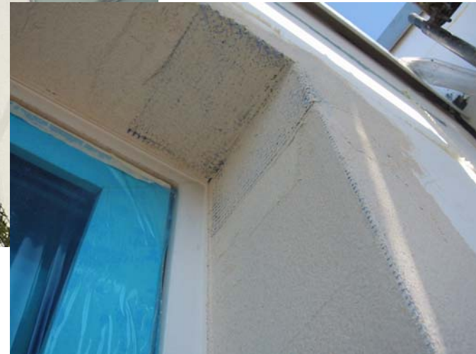
mit Gewebeerstärkung gegen Risse
