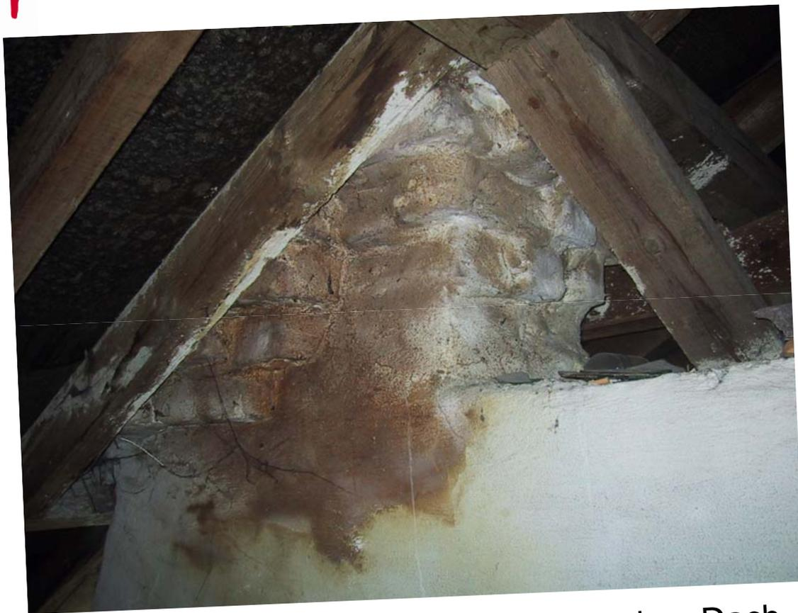
Fortgeschrittene Feuchteschäden unter dem Dach
