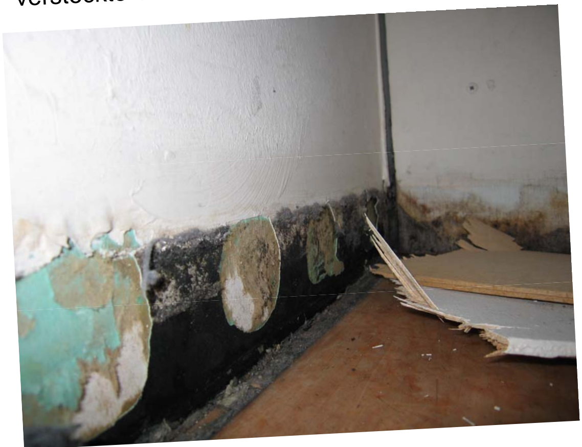
versteckte Schimmelbildung hinter Fußleisten
